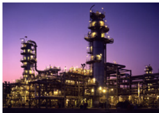
ガス処理プラント(サウジアラビア)
