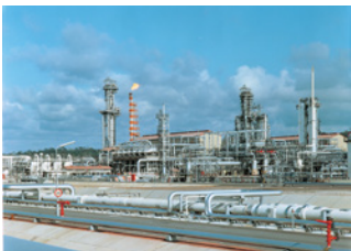
当時世界最大規模のLNGプラント(マレーシア)
