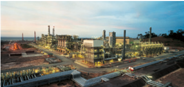
マレーシア大型商業GTLプラント
