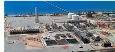
ブルネイLNGプラント
